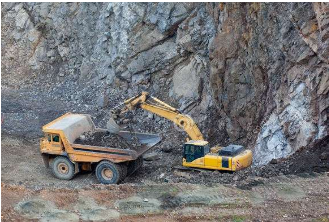
Figura 4.7 - Ponto carga com uma escavadeira carregando um caminhão fora de estrada.
