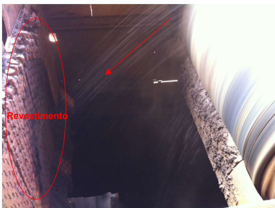
Figura 16 – Vista superior de um chute durante queda de material
