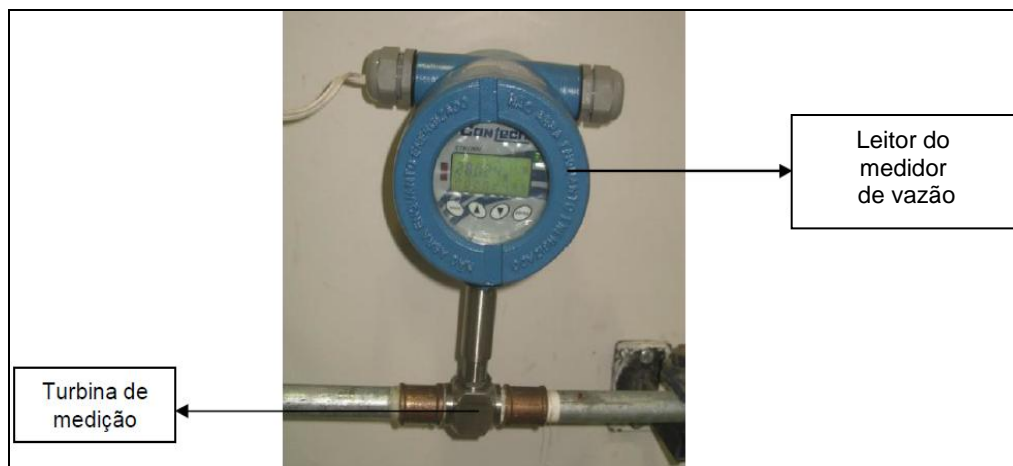
Figura 5.8 - Medidor de vazão do ar comprimido
