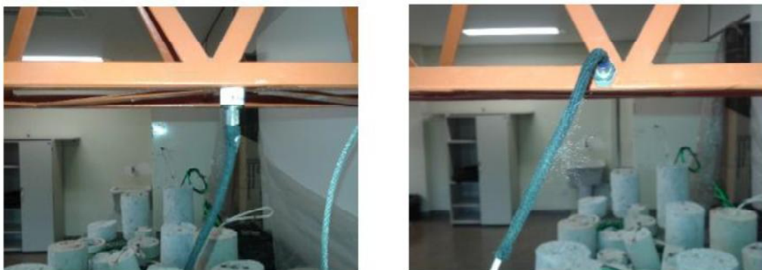
Figura 34 - Acelerômetros Vertical e Horizontal (próprio autor)
