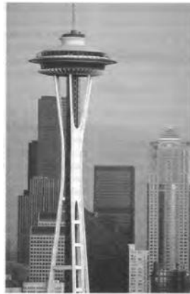
Figura 15 - Uma estrutura como modelo de um grau de liberdade (RAO, 2009, p.51)
