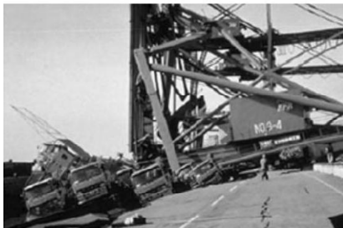
Figura 5 - Colapso de um guindaste torre (grua) devido a abalos sísmicos vibracionais (SAGIRLI; AZELOGRU; GUCLU; YAZICI, 2010, p.376)
