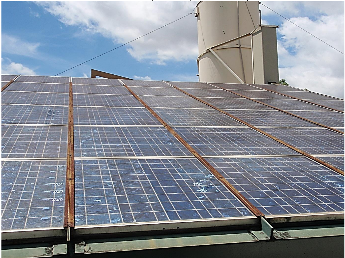
Figura 38 - Módulos fotovoltaicos instalados no Centro de Pesquisa em Energia Inteligente (CPEI) do CEFET-MG campus II com potência de 3kWp
