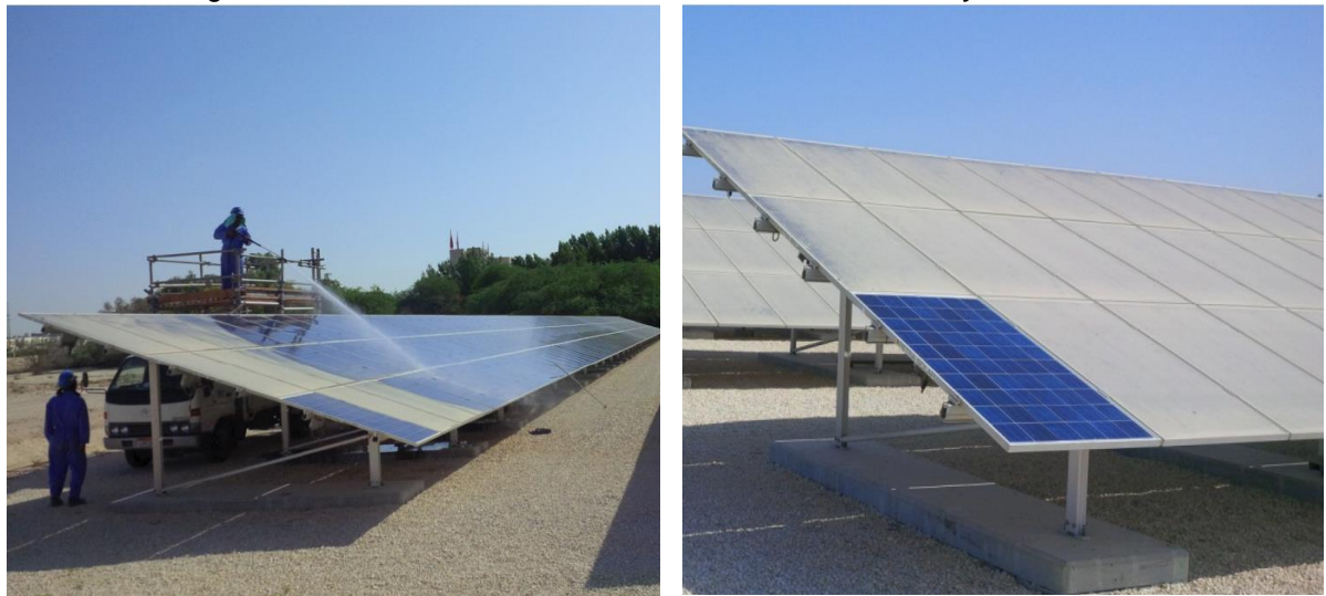
Figura 2 - Módulos fotovoltaicos PV instalados na “ University of Bahrain ”.
