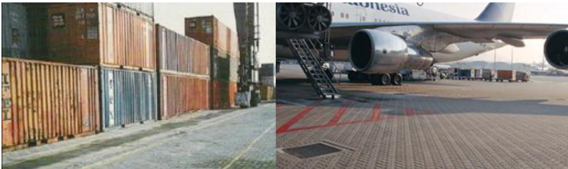
Figura 22—Um pátio de manobras no Porto em Lisboa e aeroporto de Hong Kong na China construídos com pavimento intertravado. Fonte: CIA. World Fact Book, 2013
