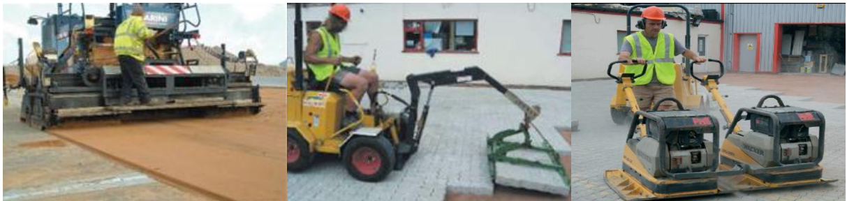
Figura 10 – Mecanização na aplicação dos blocos intertravados. Fonte: CIA. World Fact Book, 2013
