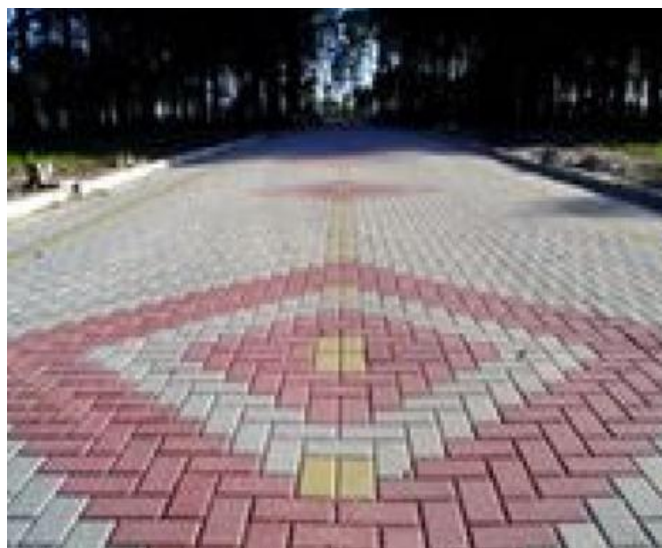
Figura 2 - Aspectos de um revestimento com blocos intertravados, pavimento flexível. Fonte: Prisma, 2007
