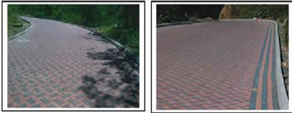
Figura 21 - Rodovia construída com pavimento intertravado na Colômbia. Fonte: CIA. World FactBook, 2013.
