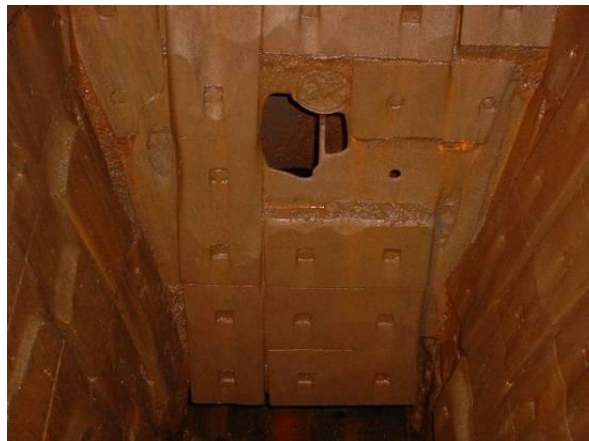
Figura 3 - Chute com furo devido ao desprendimento da placa de desgaste após 15 dias de operação
