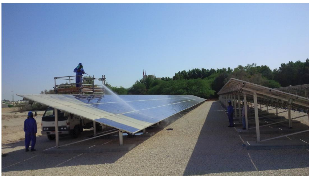
Figura 1 – Módulos fotovoltaicos PV instalados na “University of Bahrain”.
