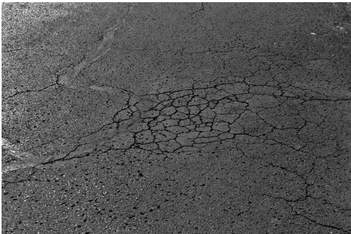
Figura 1: Fendilhamento tipo “pele de crocodilo”
