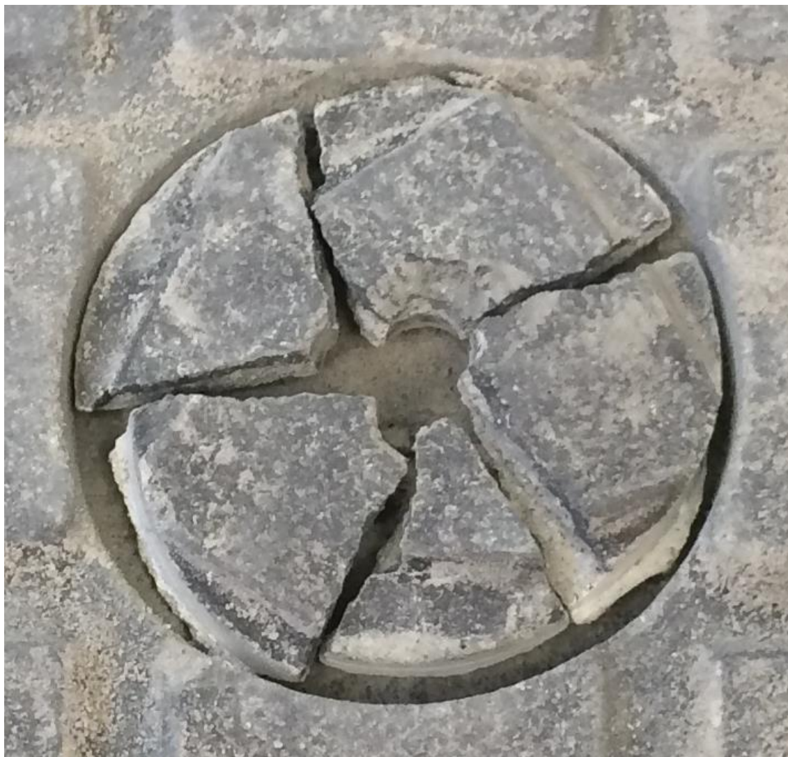
Figura 50: Ladrilho quebrado após corte com serra-copo
