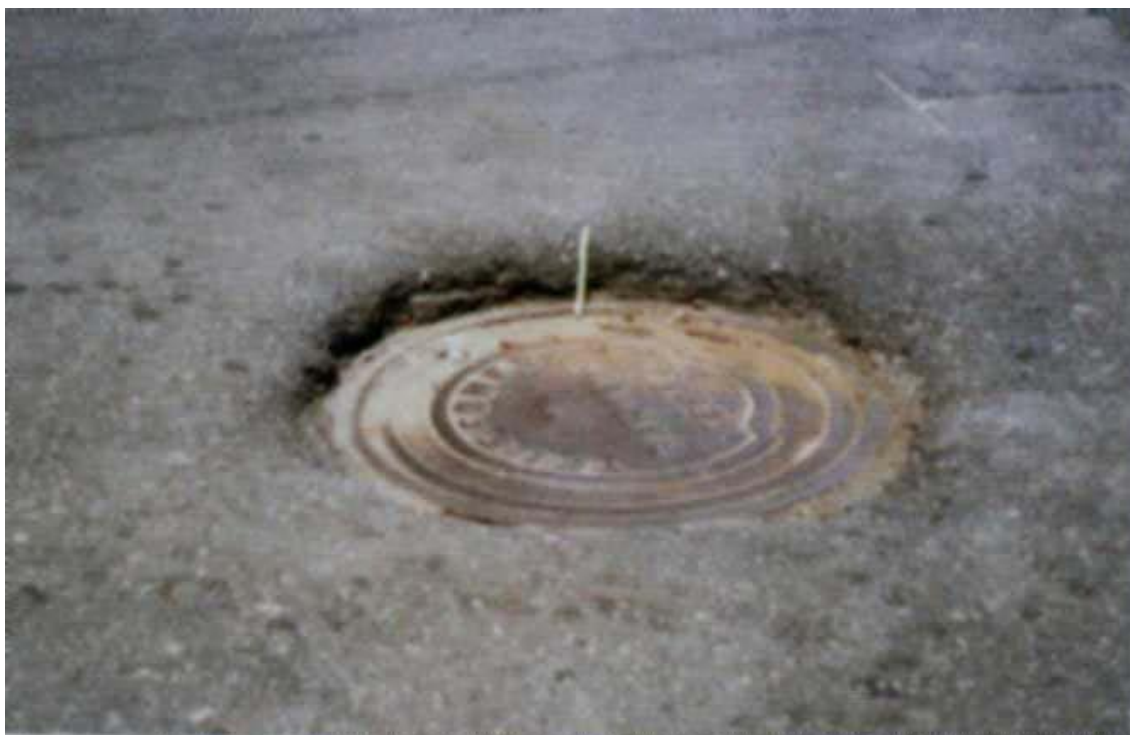
Figura 4: Desnível de 10cm entre a pista e tampão de ferro
