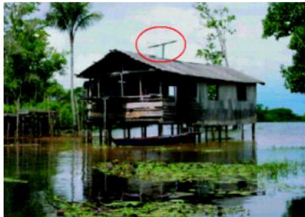
Figura 4: Sistema fotovoltaico para atendimento domiciliar (Projeto ribeirinhas).
