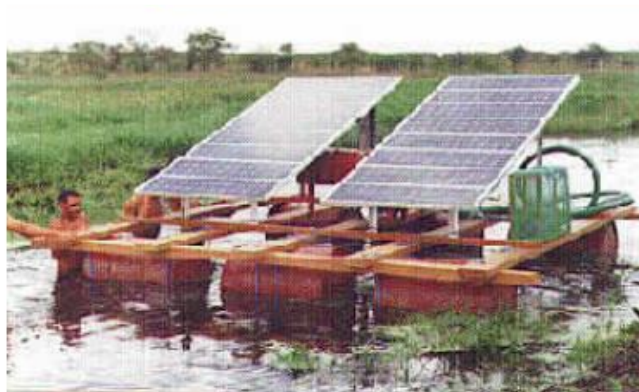
Figura 3: Sistema fotovoltaico de bombeamento de água para irrigação (Capim Grosso - BA).
